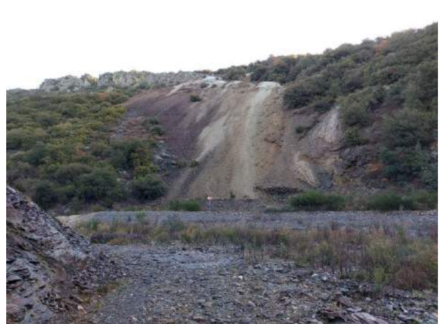
Photo 7 : Protection du pied de versé Nartau (29/12/21)
