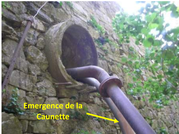
Photo 2 : Tuyau d'émergence de la mine de la Caunette
