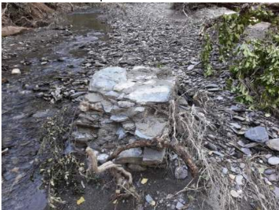
Vestiges du captage du Grésillou après les inondations (pile passerelle)
